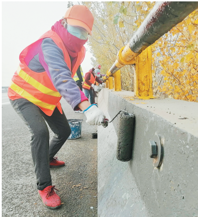
公路养护人员给桥梁护栏刷漆。
