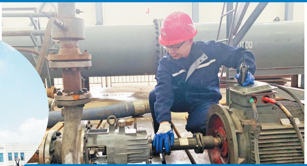
现场试验人员在进行离心泵试验前的安全检查工作。
