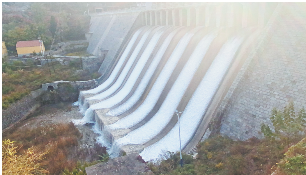
15孔闸门是西河镇田庄水库提闸泄洪、调度存水的第一道关口。
