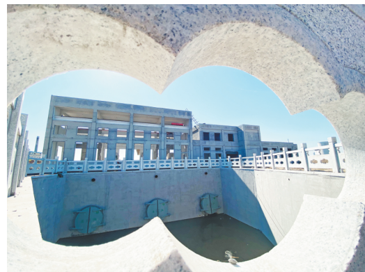
杏花河泵站将为防洪排涝加“双保险”。
