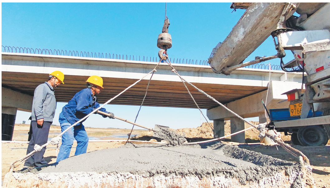
施工人员正在胜利河辛庄桥上预制板浇筑施工。
