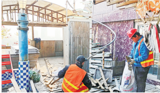
时代名都一处“空中花园”被拆除。
