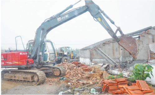
高新区保税物流园区的违建被拆除。
