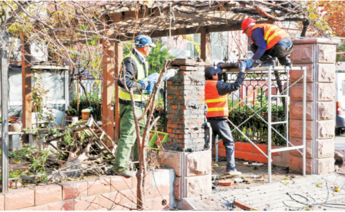
新空间社区违建被依法拆除。
