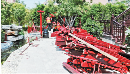
外商居住区内一处“京式院落”被拆除。
