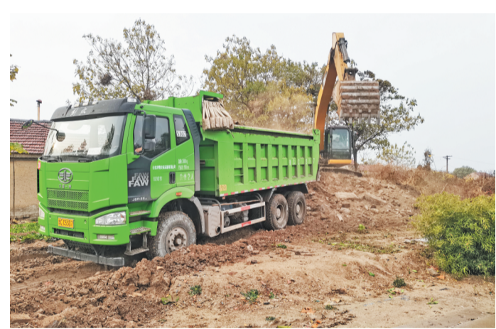
侯庄村开展人居环境综合整治,施工车辆正在清运房屋拆迁后的建筑垃圾。
