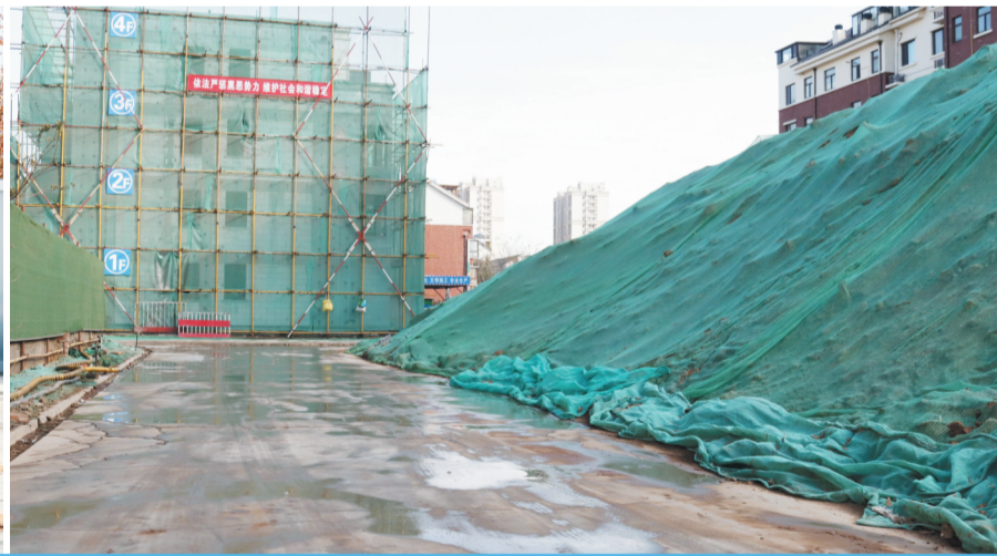
项目施工现场内道路硬化，待施工区域采用密目网全面覆盖。
