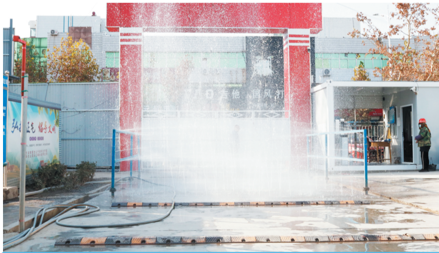
工地出入口设置车辆冲洗设施，对出场车辆进行全面冲洗。
