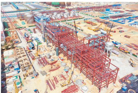
MMA主装置钢结构施工完成。
