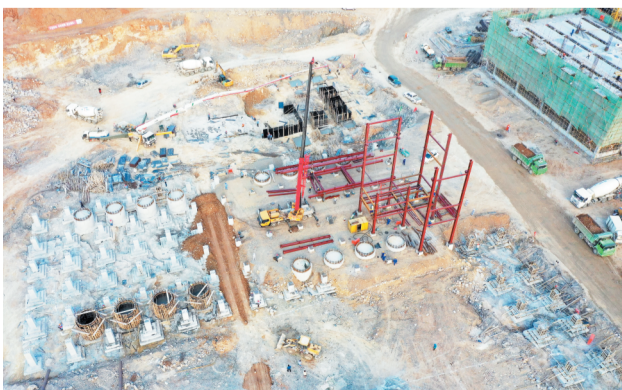
丁腈胶乳主装置钢结构施工。
