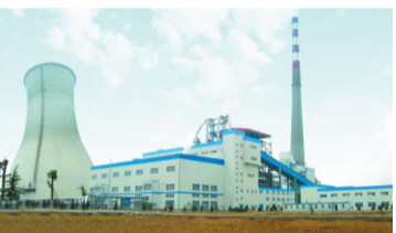
广东河源发电厂工程
