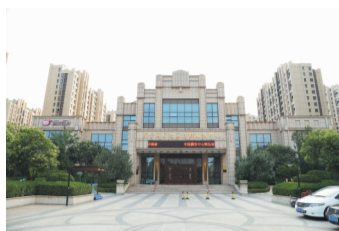
桓台东岳国际社区党群服务中心工程
