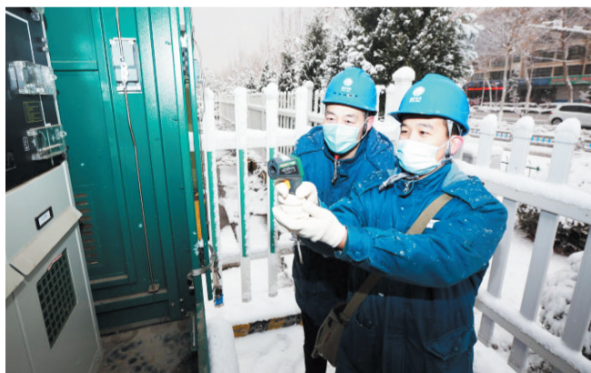
29日上午，巡线人员克服多种困难，对供电线路、城区箱变、环网柜等进行巡视。
