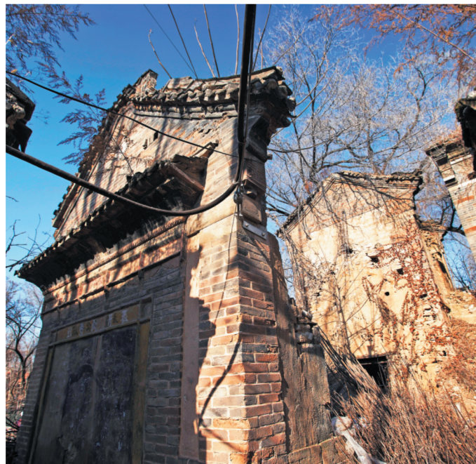
韩庄楼已经破败不堪，但门楼后面的影壁保存相对完整。
