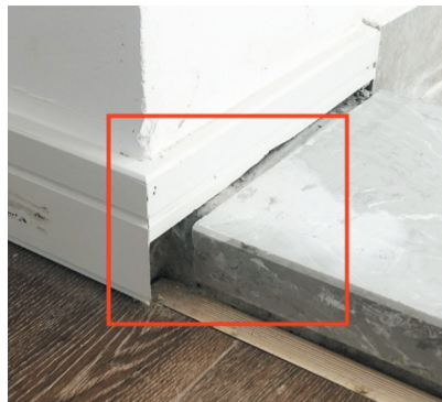
郭女士家中卧室与阳台连接部分的踢脚线有水泥裸露。
