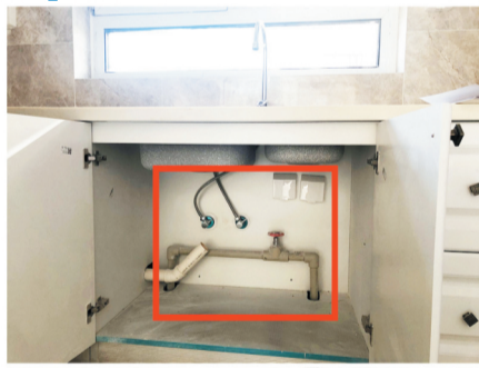
郭女士家的厨房洗菜盆下方的下水管道部分未安装。
