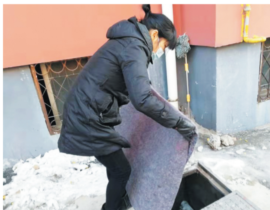
工作人员检查设施防冻情况。
