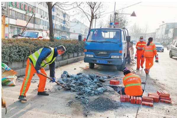
施工人员正在紧张作业中。
