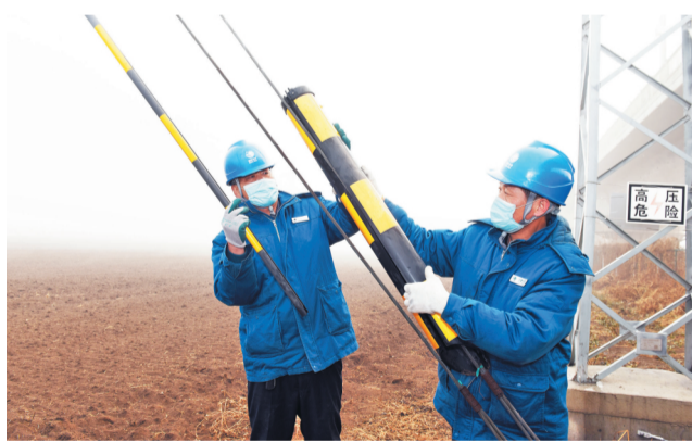
电力员工为拉线加装护套警示标志。
