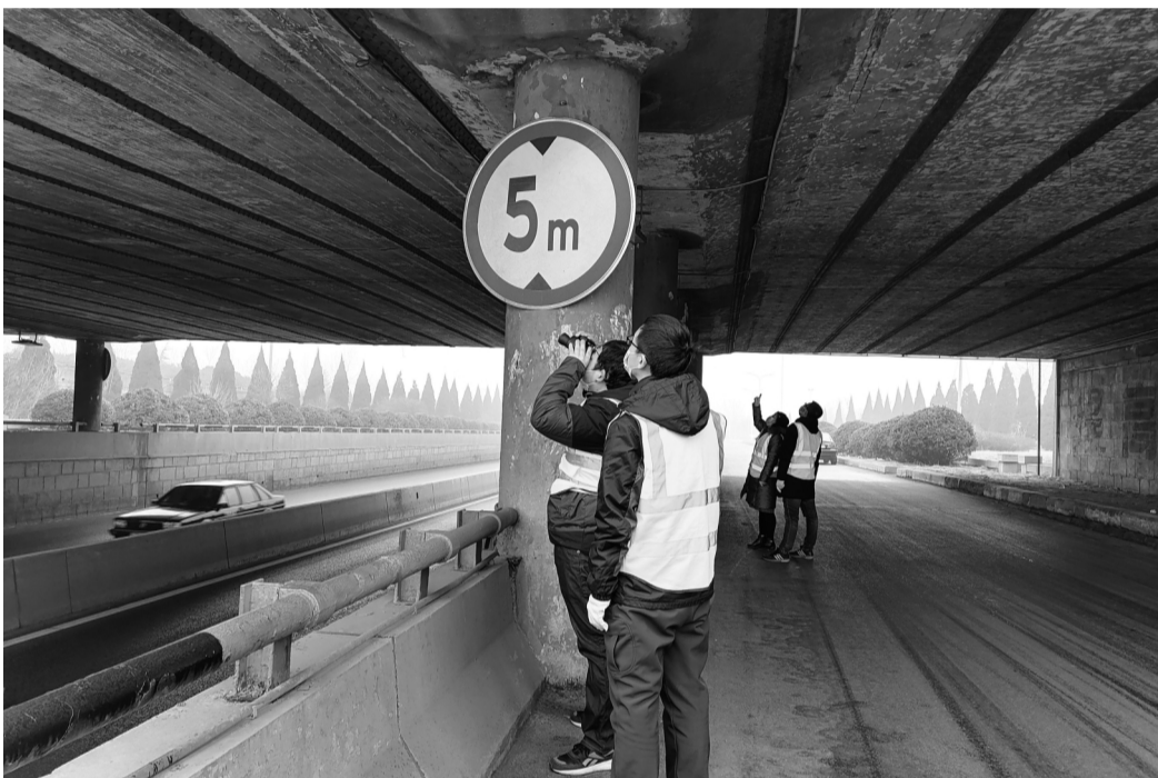
检查人员用望远镜仔细查看桥体情况。
