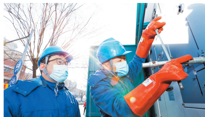
工作人员排除设备隐患。
