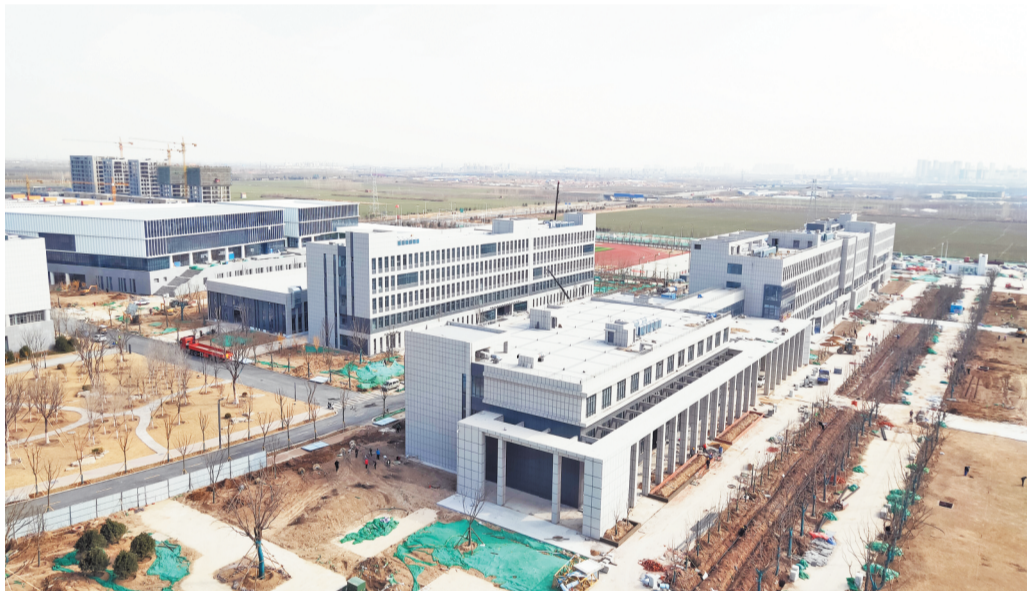
总建筑面积约9.5万平方米的公共教学区域项目建设,已进入最后冲刺阶段。
