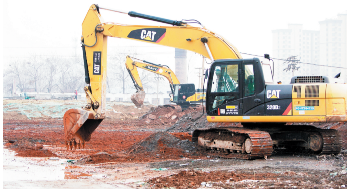
2月25日下午，淄博经开区傅家镇唐家山片区拆迁现场，挖掘机在施工。
