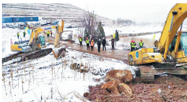
随着现场施工机械发出轰鸣声,该隧道项目正式开工。
