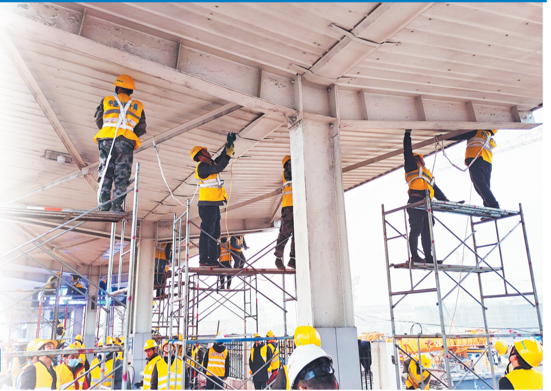
施工人员正在紧张忙碌地施工。
