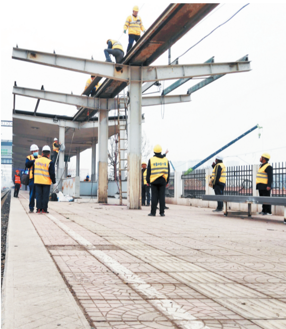
3月11日一早,施工人员正在拆除风雨棚。
