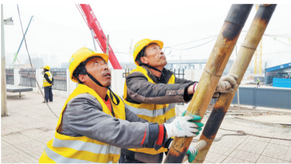
施工人员作业中。
