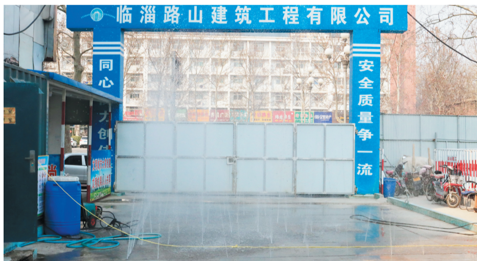
项目部门口，设置冲洗平台，对进出车辆进行冲洗。
