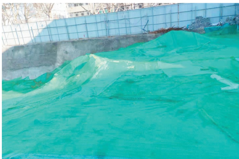
施工现场裸土用密目网覆盖。
