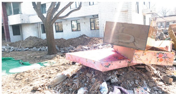
院内堆放大量建筑垃圾、生活垃圾。
