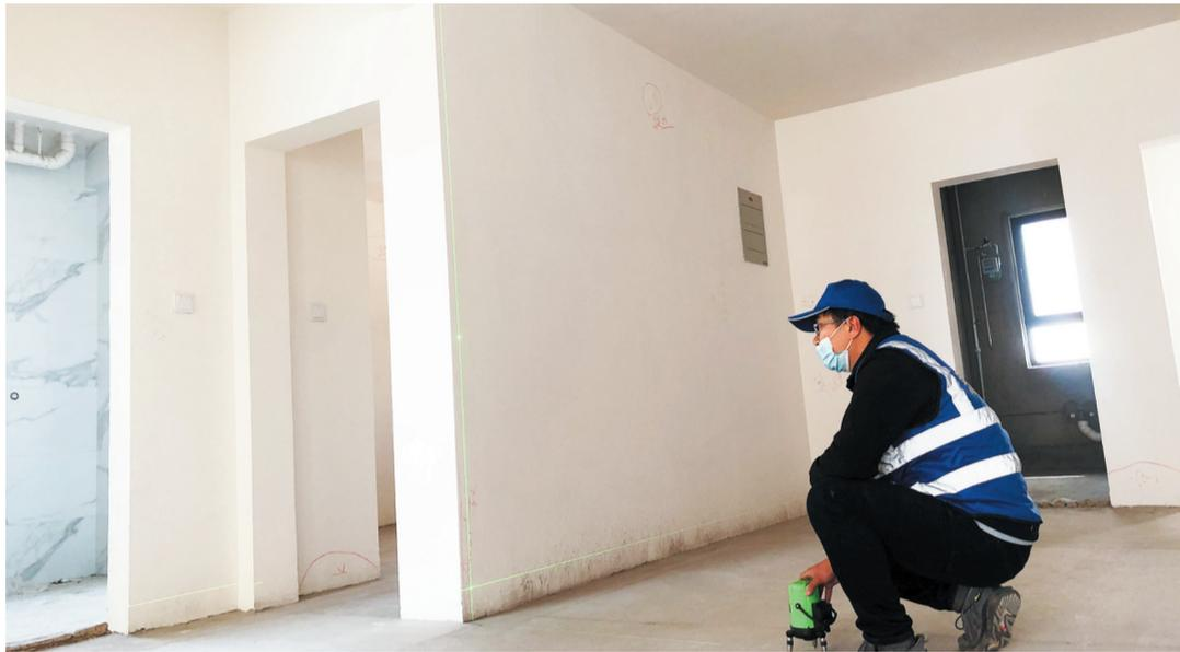
验房师用激光测距仪查验阴阳角顺直度。
