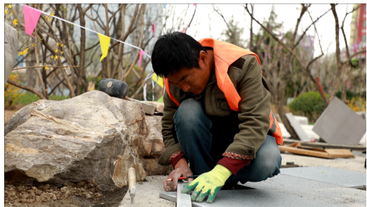
中润大道与柳泉路路口附近,工人正在游园内施工。
