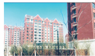
泰安美郡国际城项目
