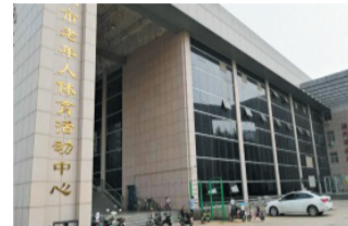
滨州市老年人体育活动管理中心能源改造项目
