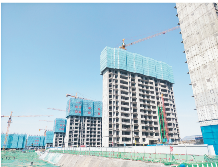
项目现场，一栋栋高楼拔地而起。
