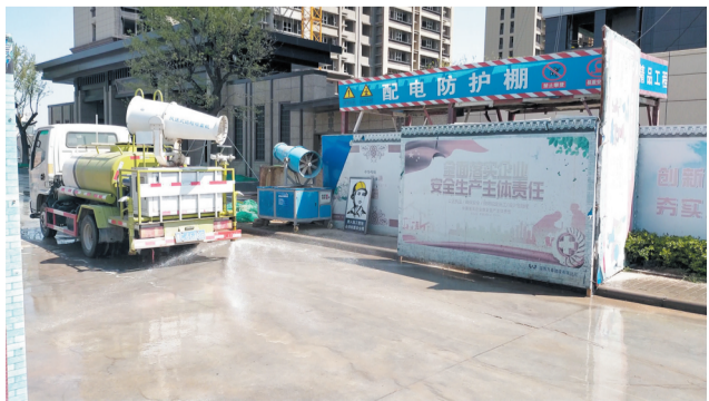
硬化道路上,洒水车定时洒水。
