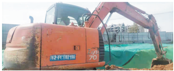
项目现场的非道路移动机械设备
