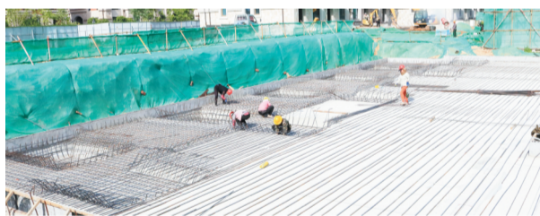
施工人员在基槽内进行施工作业。
