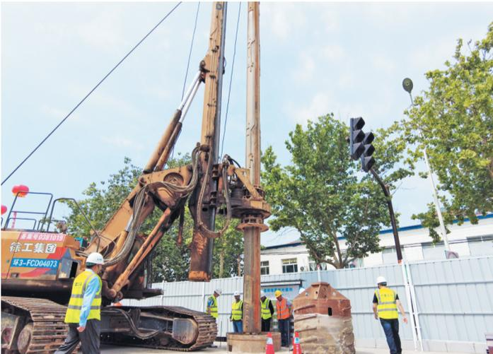
5月20日上午，在轰隆的马达声中，钻机的钻杆顺利开钻，在淄博城市快速路网宝山路段打下了第一个钻孔。宝山路是淄博城市快速路网建设项目一期工程第二个进入主体工程施工的路段。
