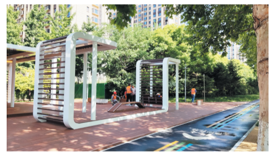
建设中的“城市会客厅”
