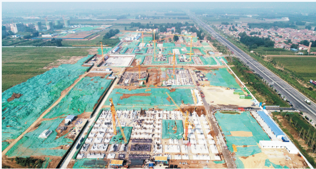
2019年9月9日，理工学院系8栋楼地基基本完工。 资料照片
