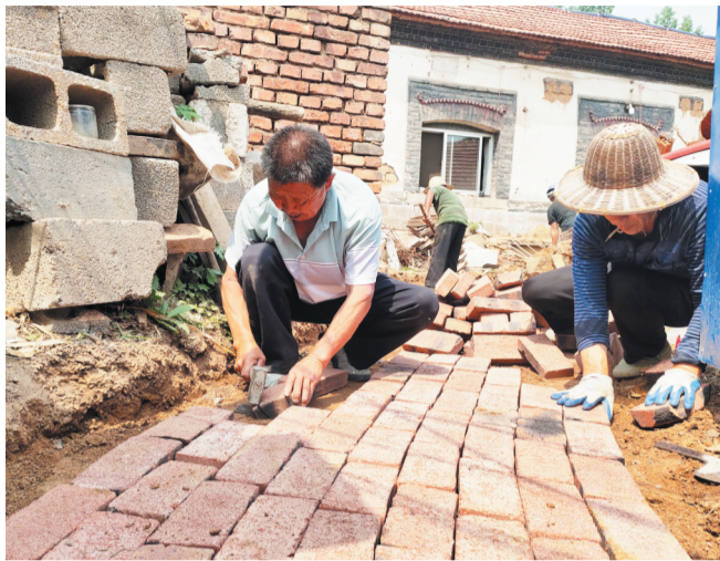
工人们正在铺设“爱心小路”。
