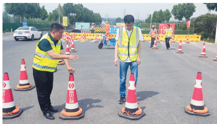
检查组对施工现场安全隐患进行排查。
