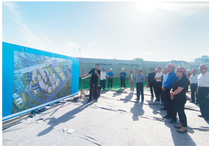
评议当天,在淄博火车站南广场还迁项目施工现场,建设方相关负责人就淄博目前最大的住宅还迁房项目的建设情况进行了详细介绍。
