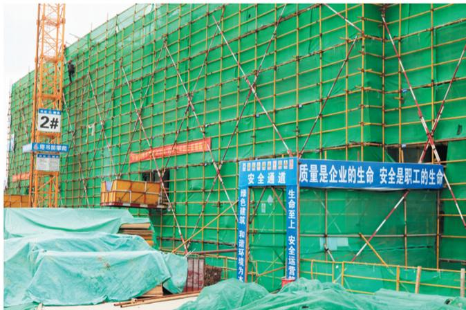
主体施工过程中,脚手架外侧采用密目网全封闭。
