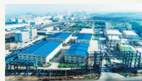
山东大成生物化工有限公司在东部化工区建设新厂。
