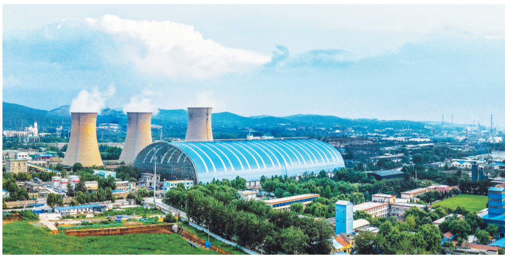
封闭后的热电厂煤场。陈永芳 摄
