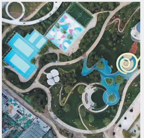
集游憩、健身为一体的淄博高新区文体公园主体结构已经基本完工。 大众日报淄博融媒体中心记者 王兵
