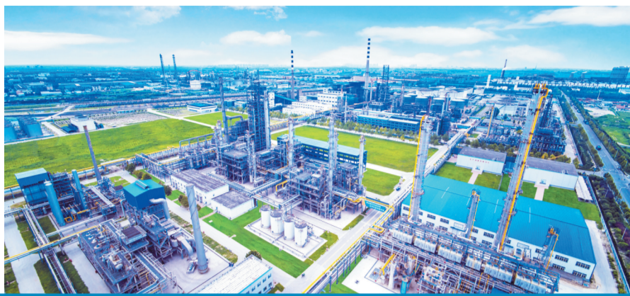
山东汇丰石化集团有限公司生产装置区
