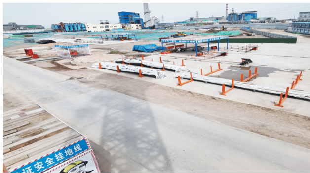
博汇集团45万吨/年高档信息用纸及化机浆项目
