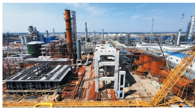
金诚石化集团160万吨/年催化裂化升级改造项目
