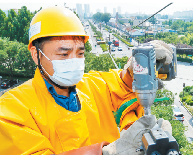
临淄供电公司员工高乾顶着酷暑带电作业。
