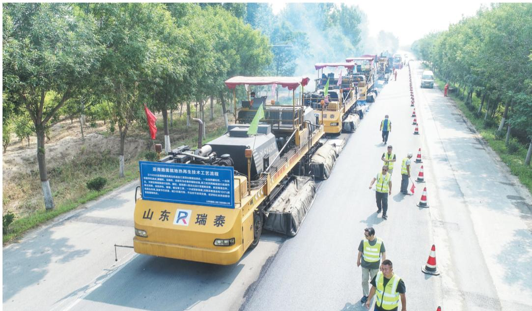
滨州市普通国省道干线路面提升工程采用挖补罩面和就地热再生技术等新技术。
