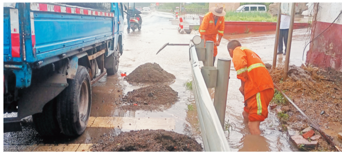
施工人员正在清理道路边沟。
