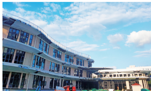
齐丰幼儿园建筑主体已经完工。
