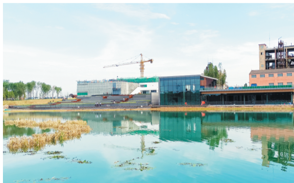
高新区“双创公园城”展厅正在建设中。
