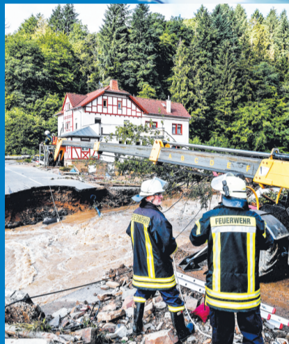
7月15日，消防人员在德国舒尔德查看被洪水冲毁的道路。
