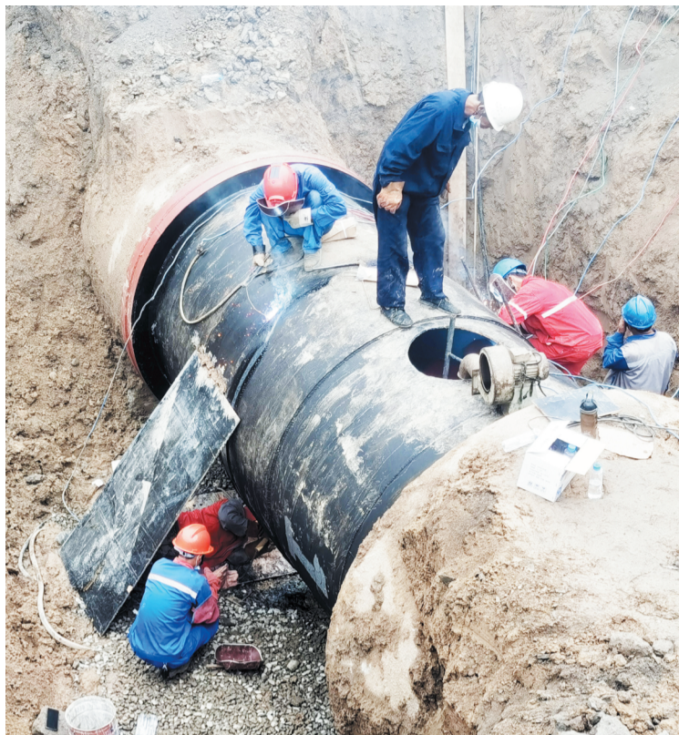
8月12日上午11点，工人正在焊接新管道。
