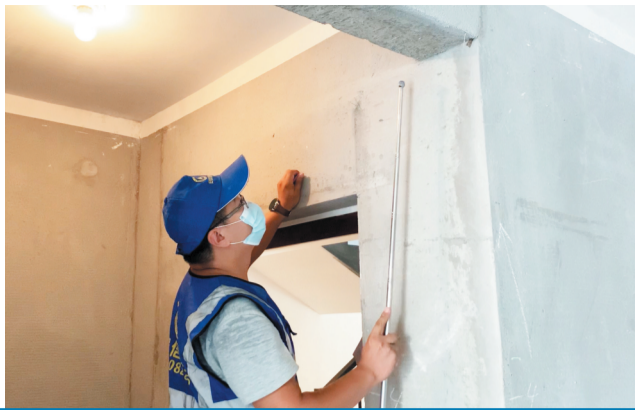
墙面空鼓检查
