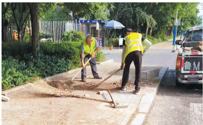
施工人员对缘石坡道进行提升改造。
